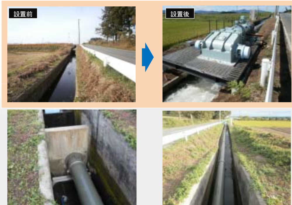
取水地点 (取水壁の設置)
