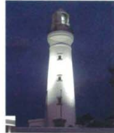
犬吠埼灯台 太陽光発電LEDライトアップ 実証実験
